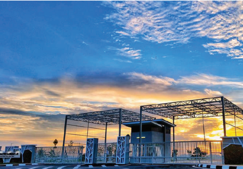
Pintu gerbang dengan rekabentuk moden dari kombinasi brick dan mild steel
